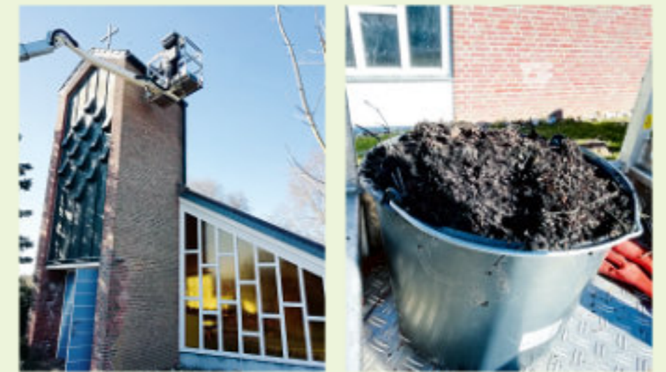
Vier große Eimer voll hat es aus den Regenrinnen gebracht. Jetzt dürfte der Glockenturm wieder sicher sein.
